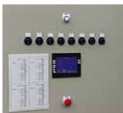
各機械のON/OFFスイッチ(半自動・単動)
