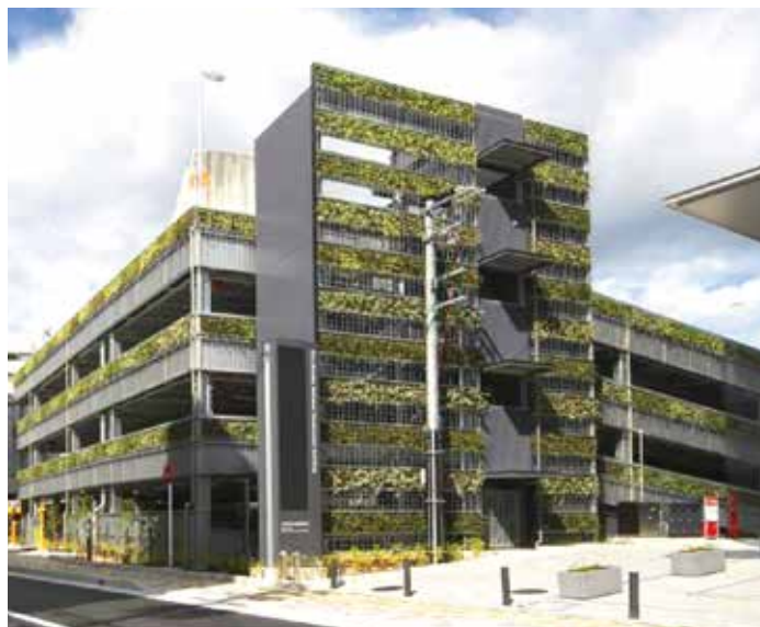
大津合同庁舎駐車場壁面
