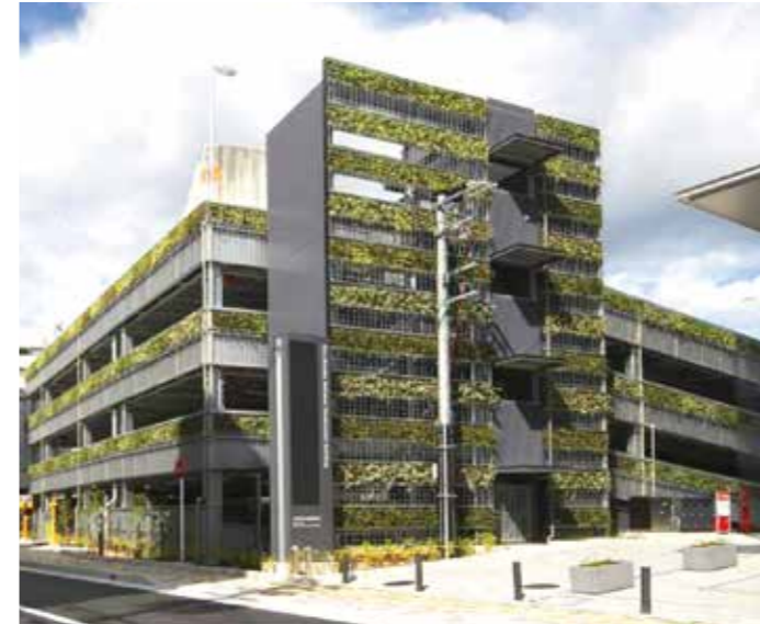
大津合同庁舎駐車場壁面
