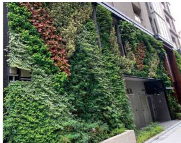
東京都港区 ビル
